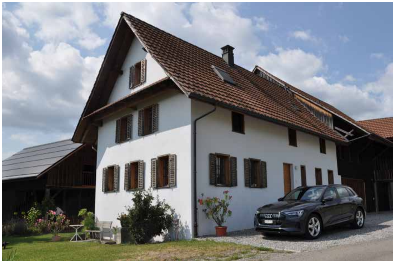
Die 109 m 2 grosse Photovoltaik-Anlage auf dem Dach des Holzschopfes liefert Strom für das sanierte Bauernhaus (Baujahr 1823) und die Stöckli-Wohnung in der Scheune. Neu wird der Solarstrom auch noch für das Elektroauto genutzt.
