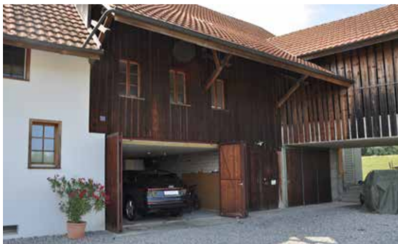
Über der Garage liegt die bewohnte sanierte Scheune. BILDER HEV SCHWEIZ
