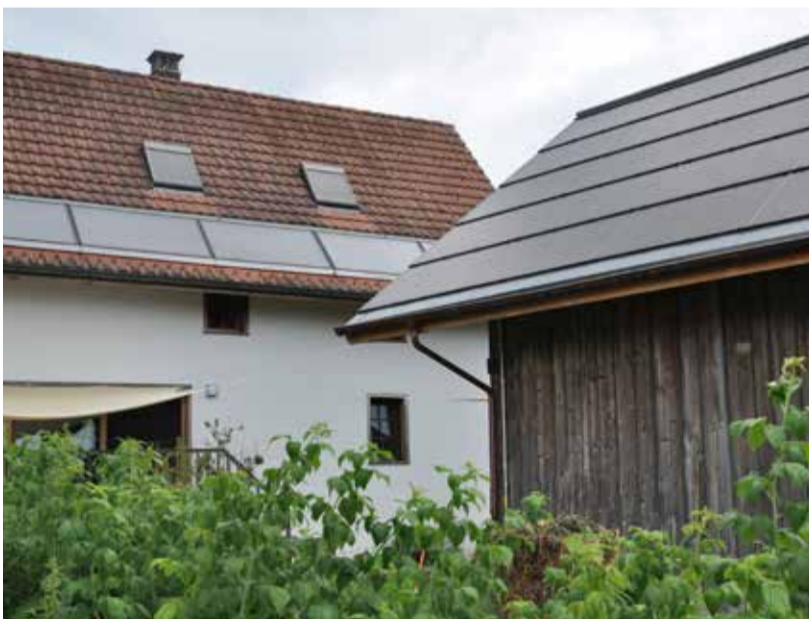
Auf dem Hausdach befindet sich die thermische Solaranlage fürs Warmwasser, auf dem Dach des Schopfes süd- und nordseitig die Photovoltaikanlage.
